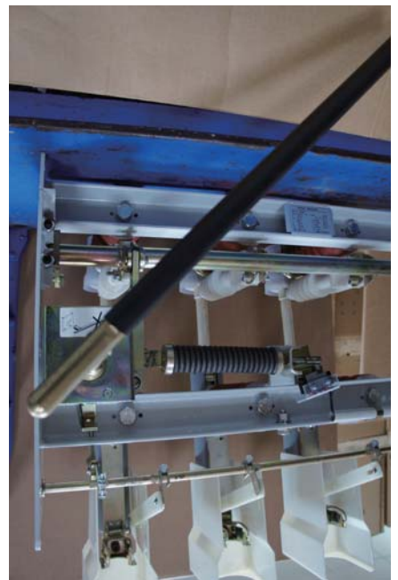
(5)投入、 已儲能 。 (彈簧變成水平/壓縮)
